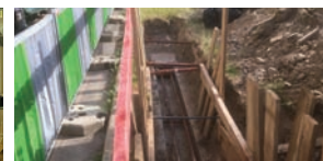
Renouvellement des réseaux
